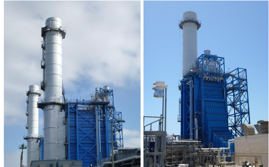
El Segundo 550 MW Combined Cycle Power Plant, California, USA.
